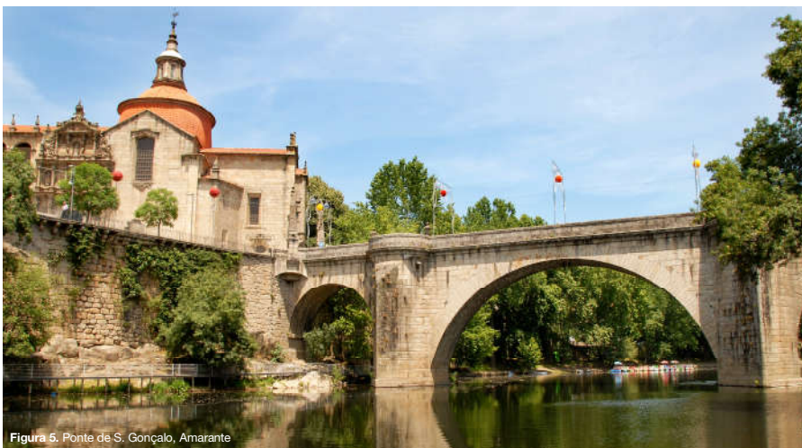
Figura 5. Ponte de S. Gonçalo, Amarante
